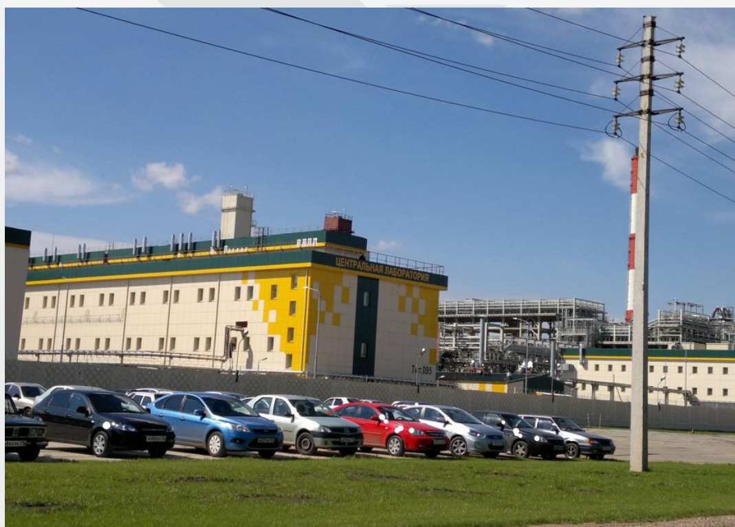
2011-2013 гг. Комплекс нефтеперерабатывающих заводов «ТАНЕКО» г. Нижнекамск. Устройство НВФ с облицовкой АКП «АЛКОТЕК» (тит. 72, 75, 112, 34.)
