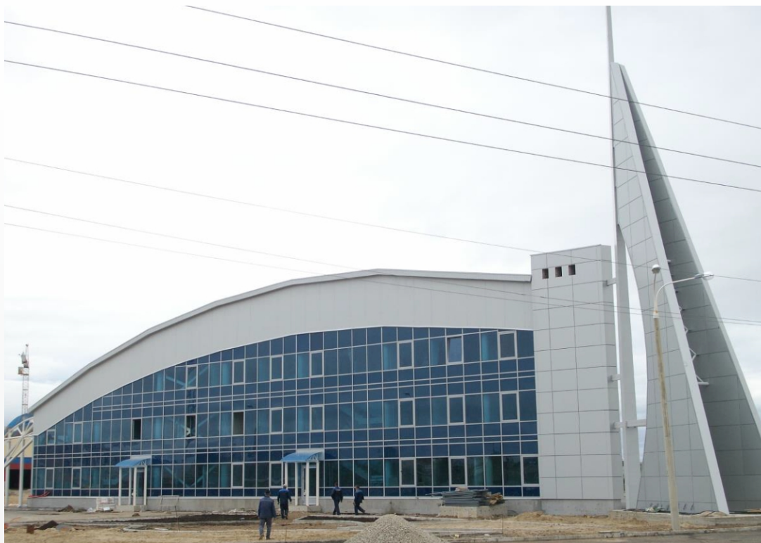
2011-2013 гг. Комплекс нефтеперерабатывающих заводов «ТАНЕКО» г. Нижнекамск. Устройство НВФ с облицовкой АКП «АЛКОТЕК» (тит. 72, 75, 112, 34.)
